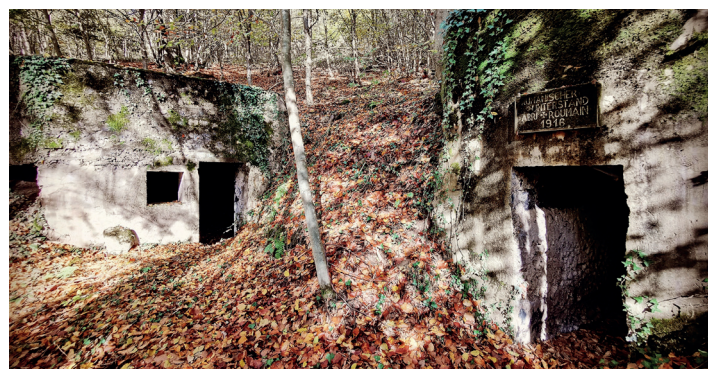
Un abri composé de roche, béton et tôle ondulée. Un plafond épais de 1,50m protégeait des bombardements français.
